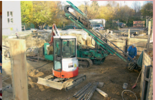
Hier entsteht unser neuer Anbau
